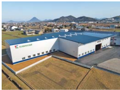
川上板金工業所工場
