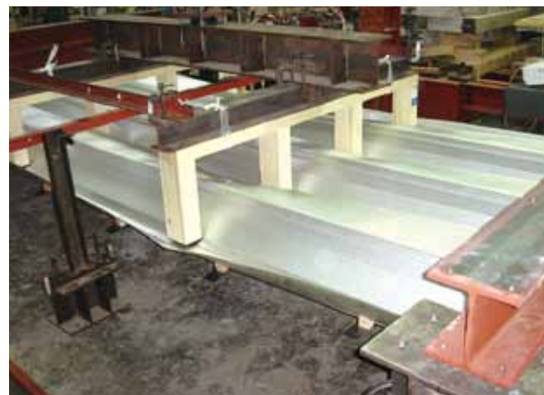
Z500 クローザールーフ 損傷状況
