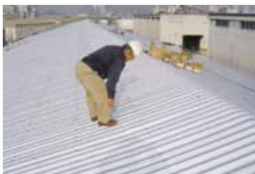
施工完了後、自主検査
