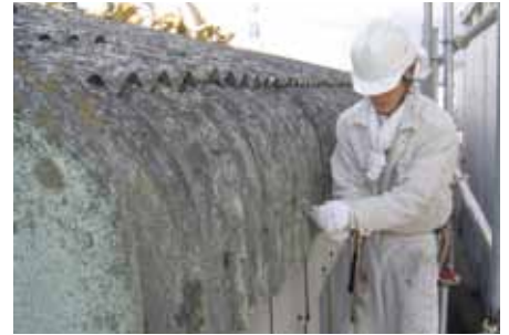
スレート屋根 谷部分清掃
