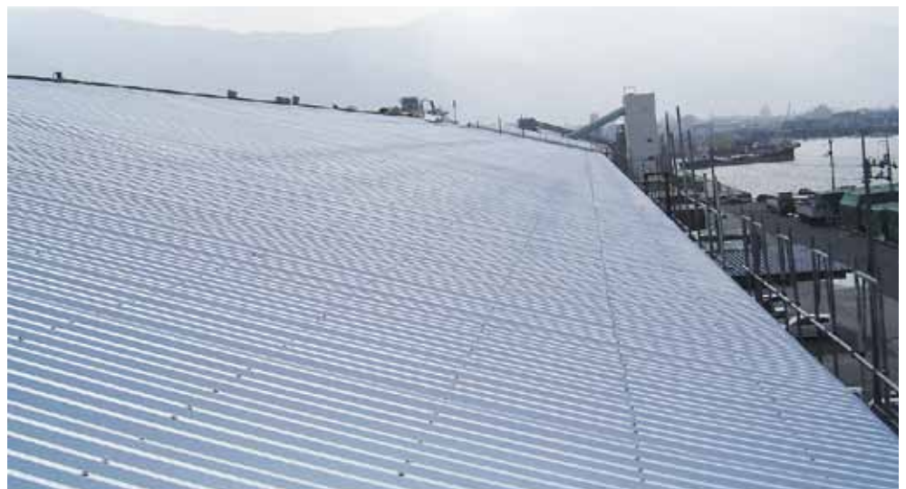
屋根施工完了
