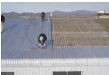
施工中（仮葺せ中）
