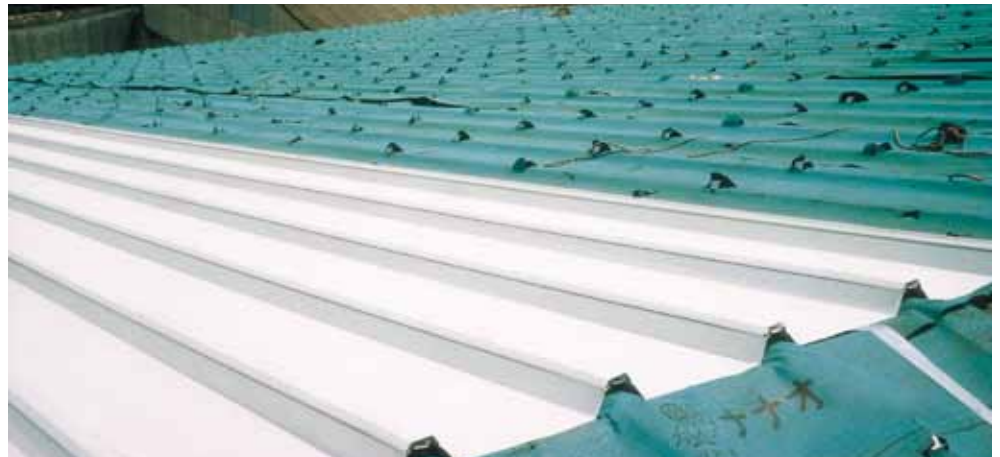
スーパーroof施工状況
