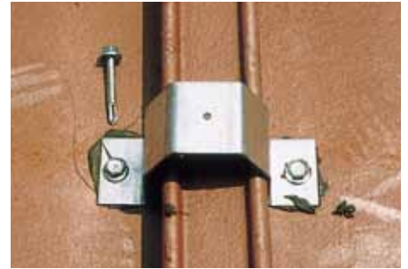
タイトフレーム固定状況
