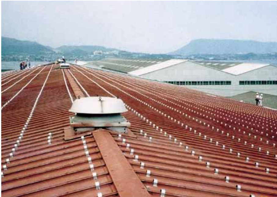
タイトフレーム取付状況
