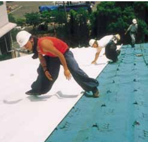
スーパーroof施工中
