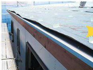
唐草(アルミ押出材)の施工
