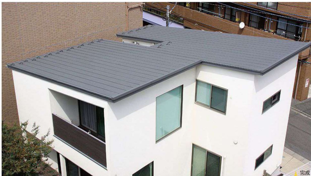
唐草(アルミ押出材)の施工
