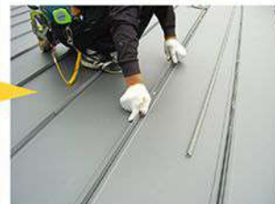
棧カバー(定尺)の施工
