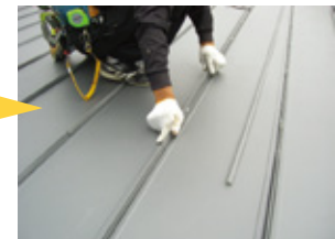
棧カバー(定尺)の施工
