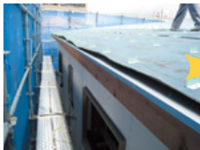
唐草(アルミ押出材)の施工
