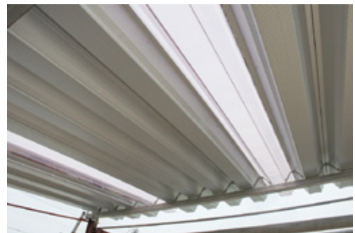
天井側から撮影
