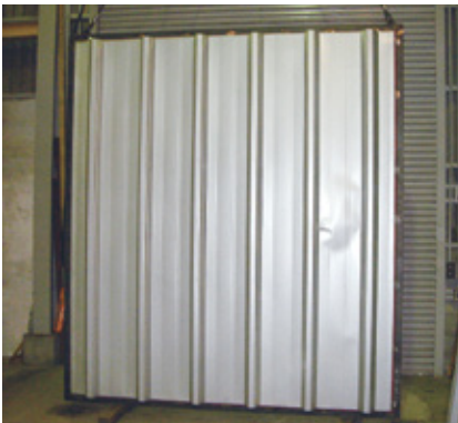
スーパーーフ66の損傷状況
