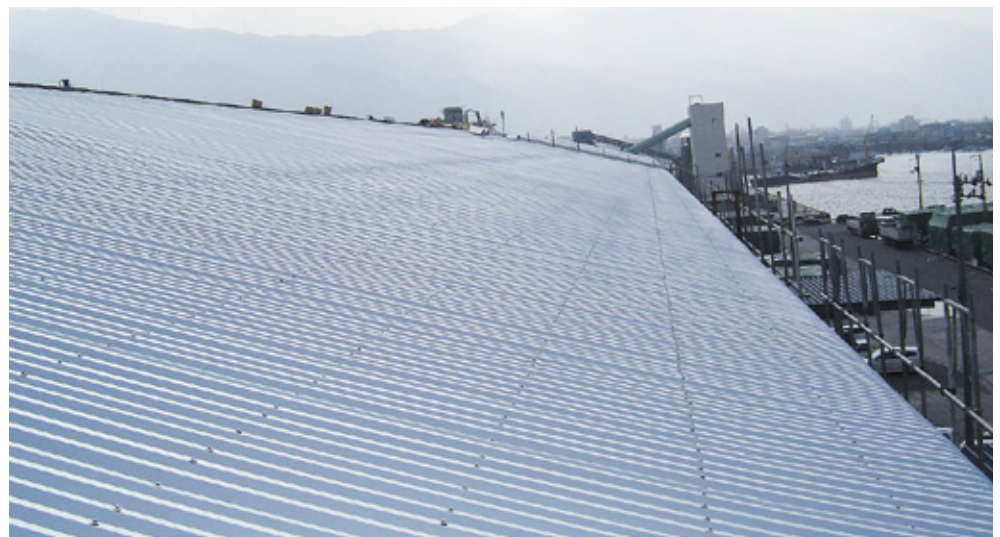
屋根施工完了
