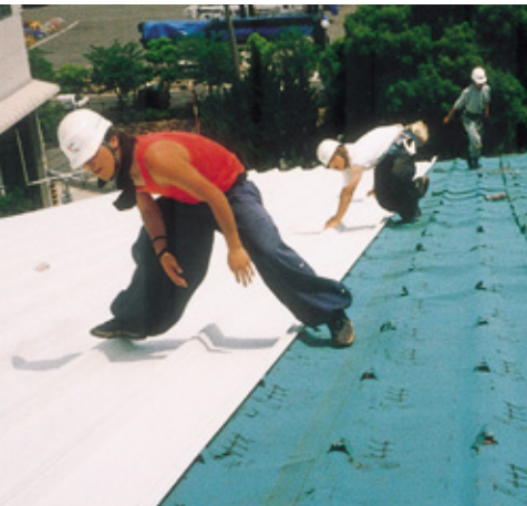
スーパーroof施工中
