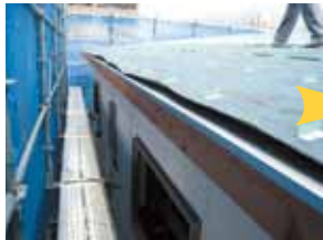
唐草(アルミ押出材)の施工
