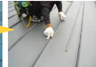
棧カバー(定尺)の施工
