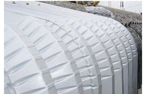
施工中 軒先、軒曲げ加工
