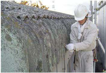
①スレート屋根 清掃
