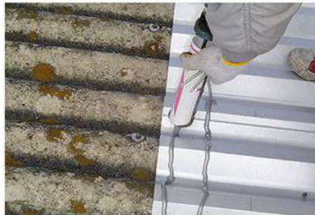
施工中 重ね部分 ダブルコーキング
