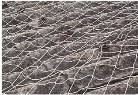
②フックボルト切断
