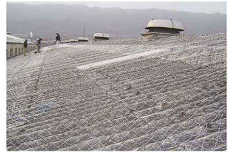
③安全ネット敷込
