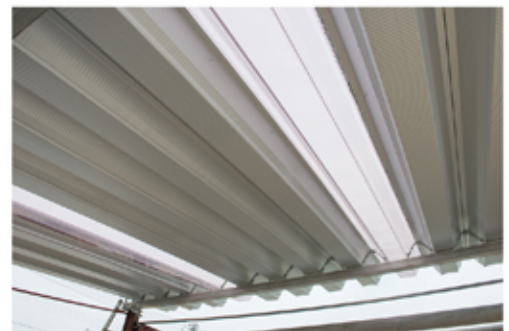
天井側から撮影
